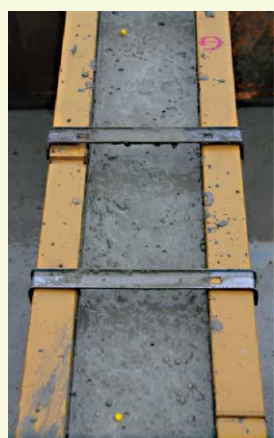
6. 生コン打設完了
