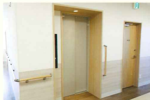
エレベーター
