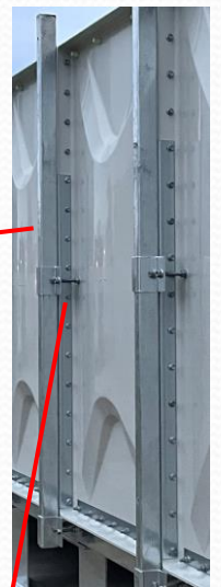
外部補強 (中央部)
