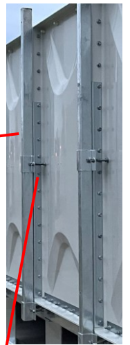
外部補強 (中央部)
