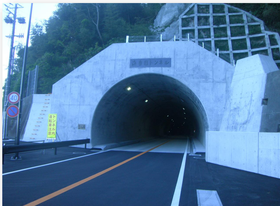
大崩れ海岸 浜当目トンネルH29.3.13開通(坑内排水工施工)
