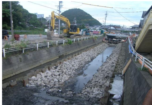
石脇川護岸改修工事 根固め工施工完了
