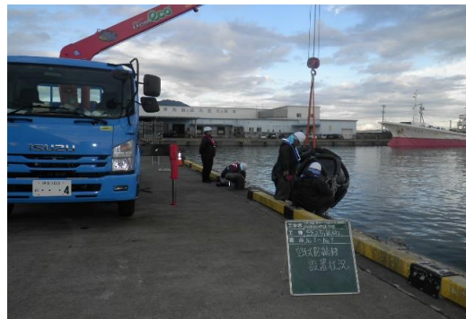
焼津漁港防舷材設置工事 防舷材設置状況
