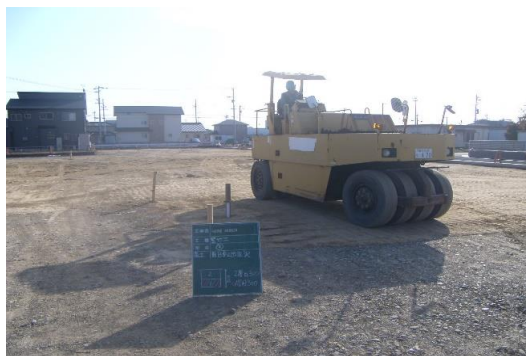
134BL整地工事 盛土転圧状況
