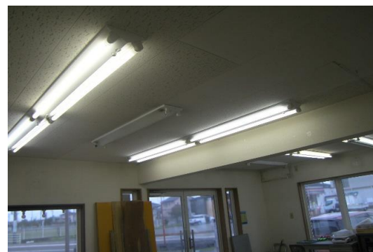
・余分な蛍光灯の取り外し
