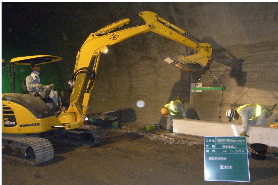
浜当目トンネル坑内排水工設置工事 トンネル坑内側溝据付状況
