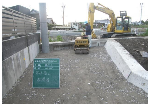
150号道路新設工事 路床盛土転圧状況
