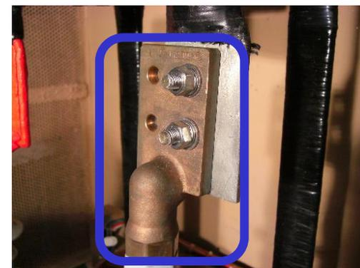
羽子板端子(青枠の部分)に絶縁処理施工を行った。
